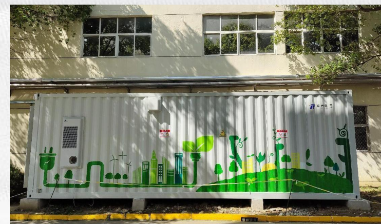
项目地点: 越南 项目配置: 储能集装箱项目 项目规模: 400kW/1.6MWh 项目进展: 成功验收
